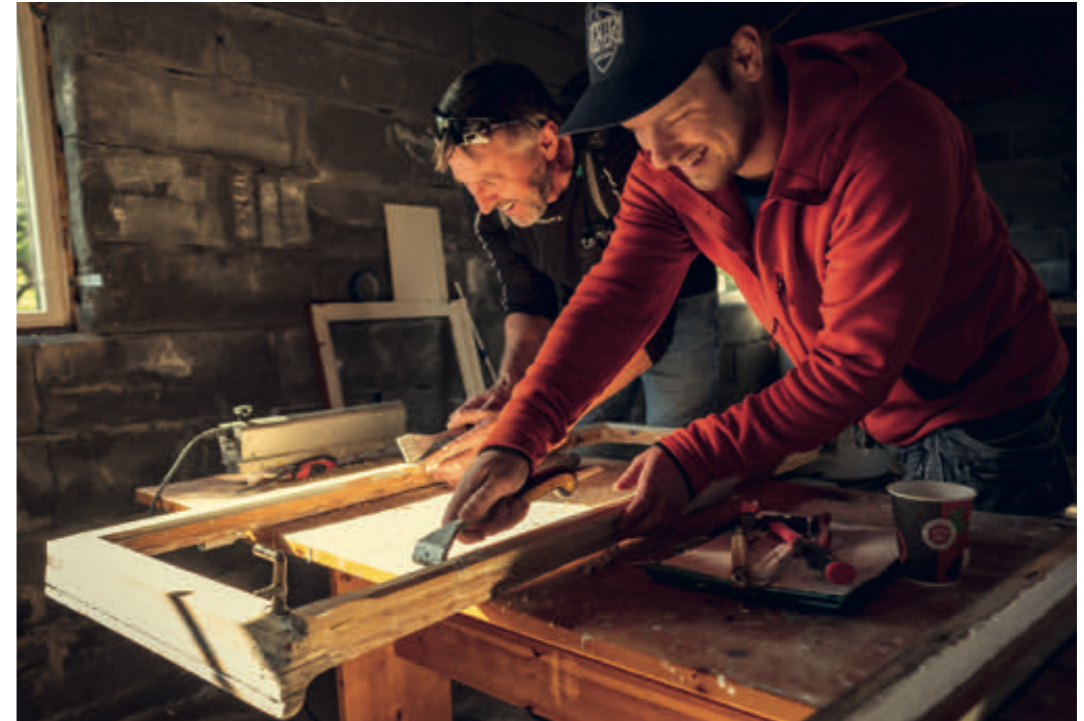
Godt samarbeid gjør arbeidet til en fryd. Foto: Bård Gundersen / Fortidsminneforeningen
