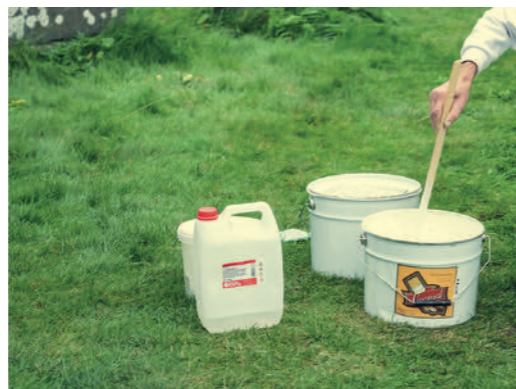
Det er vanlig å tynne ut linoljemalingen med terpentin, slik at de ulike malingslagene går fra mager til tykk. Foto: Bård Gundersen / Fortidsminneforeningen
