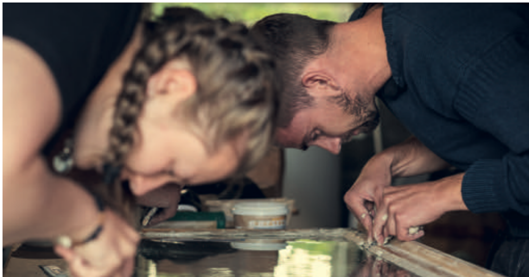
Med jevne vinkler får du et flott resultat. Pass på at ingen stifter stikker ut gjennom kittet. Foto: Bård Gundersen / Fortidsminneforeningen
