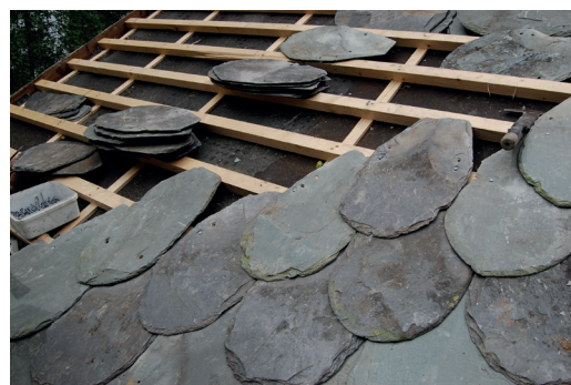
Sløyfer og lekter under skifertekking. Foto: E. Engen/Kulturminnefondet, 2018
