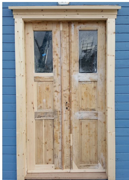
Istandsatt dobbeltfløyet dør. Foto: E. Steinsli, 2018
