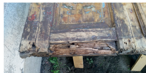
Gammel dør med råteskade. Foto: E. Steinsli, 2018
