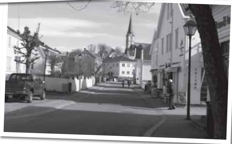
LILLESAND: Strandgata innenfor bevaringssonen. I 2022 opplevde man bygget helt til høyre (bak treet) at det ble foretatt fasadeendring som ikke fulgte retningslinjene og utført uten tillatelse. Foto: Peter Lukas.
